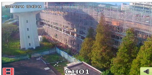
研究生第三宿舍興建工程施工情況-1
