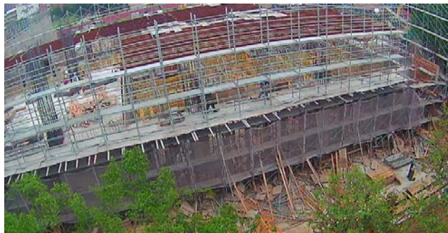
博愛校區生醫工程施工情況-1
