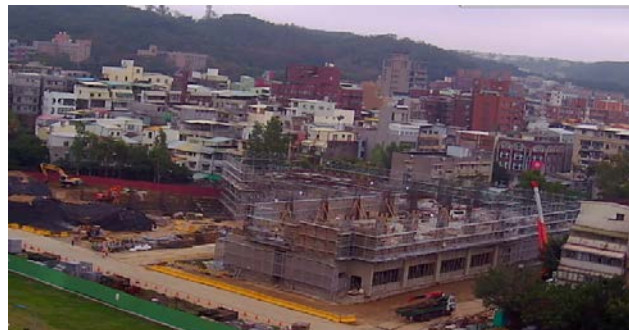
博愛校區生醫工程施工情況-2
