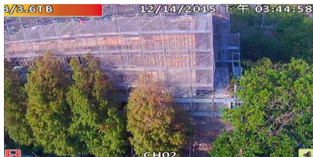
研究生第三宿舍興建工程施工情況-2
