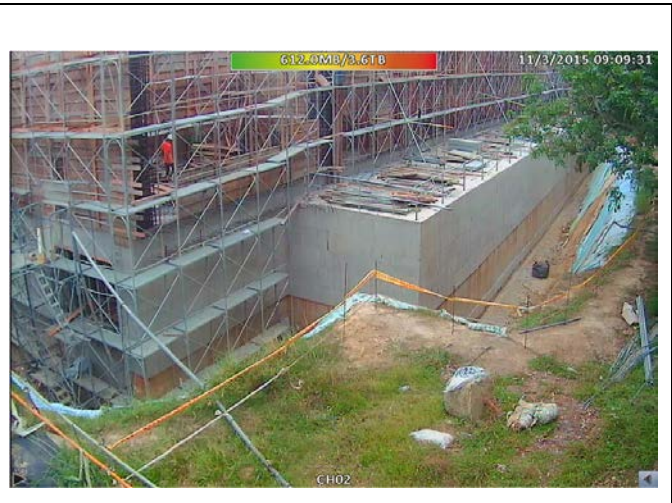
博愛校區生醫工程施工情況-2
