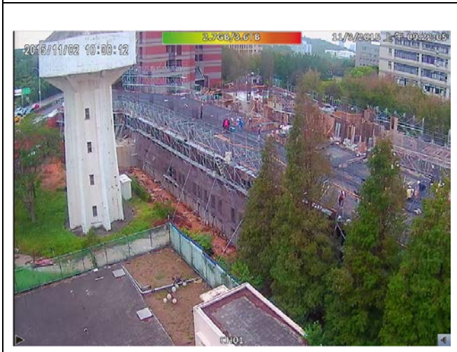
研究生第三宿舍興建工程施工情況-1
