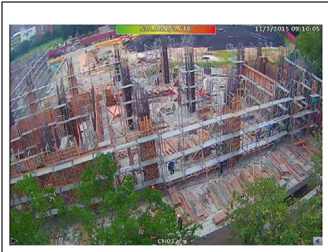
博愛校區生醫工程施工情況-1
