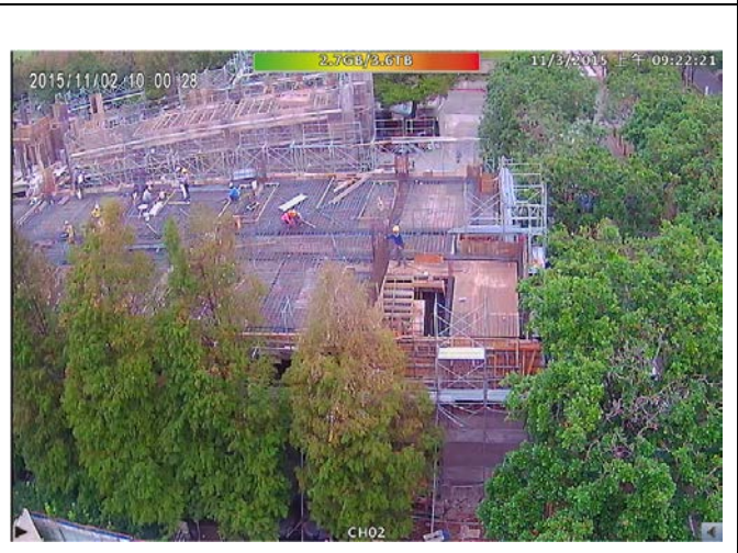
研究生第三宿舍興建工程施工情況-2
